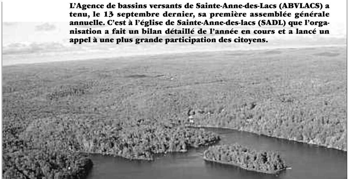
Vue aérienne du bassin versant Ouimet, qui a une superficie de 4,8 km carré.
